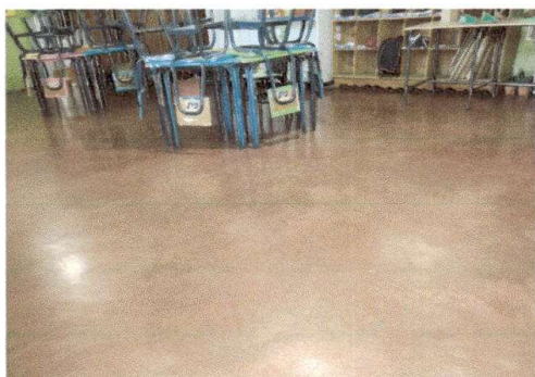
Foto 3: Modulo 1 Sustitución de torta de concreto por piso cerámico
