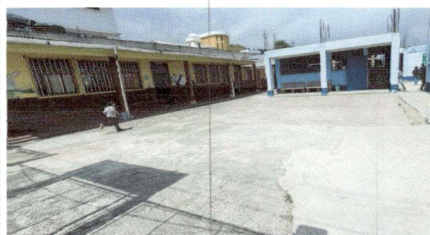
Foto 4: Patio Modulo 1 Sustitución de piso de torta de concreto por piso de torta de concreto
