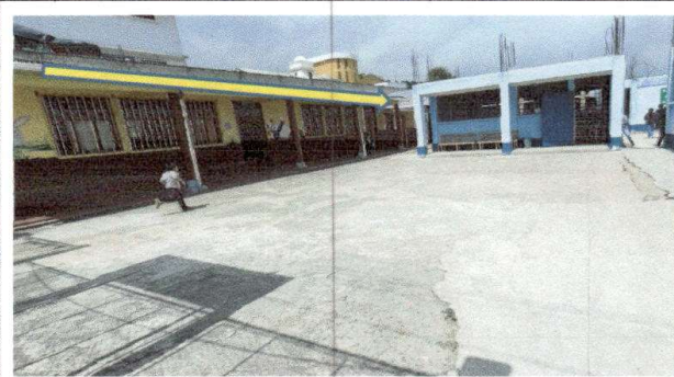
Foto 6: Reparación de drenaje
