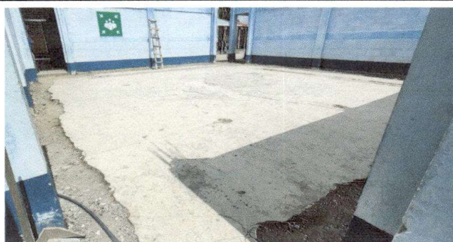
Foto 5: Patio modulo 3 Sustitución de torta de concreto por piso cerámico
