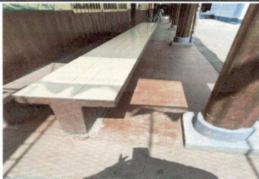
Foto1: Modulo 1 Sustitución de piso de torta de concreto por piso cerámico
